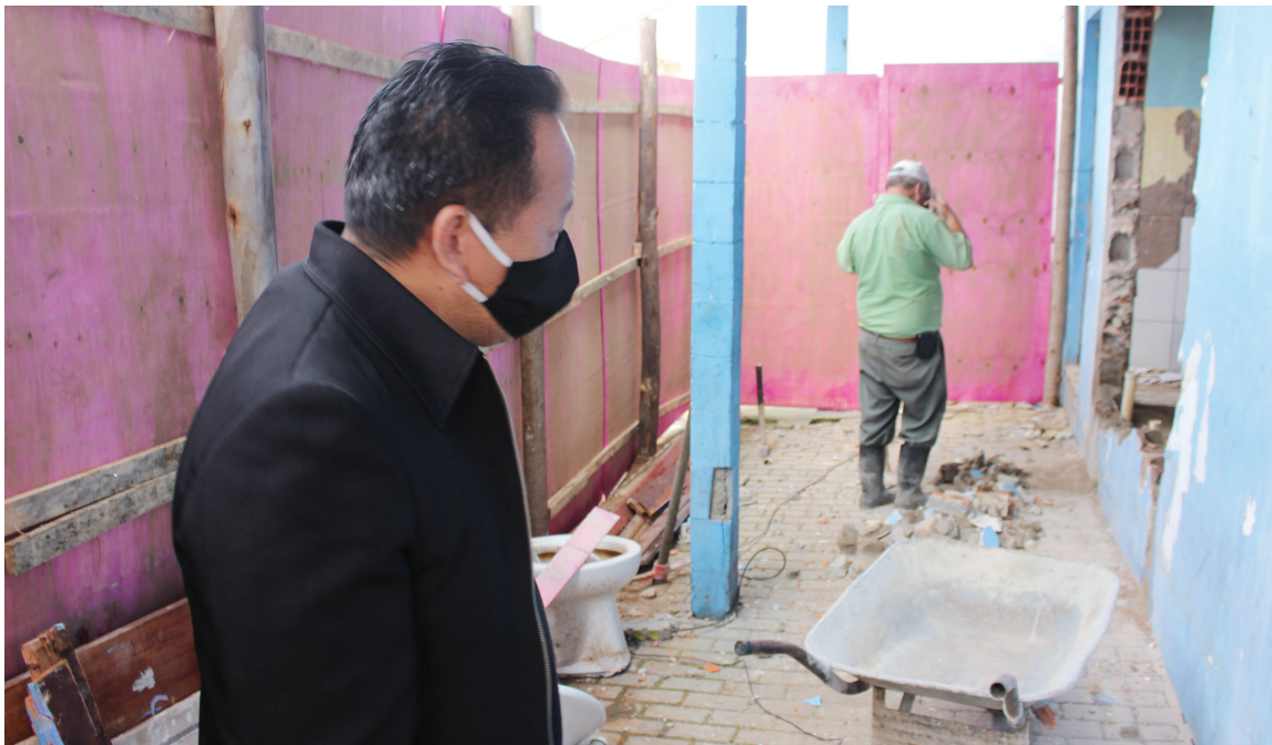
Prefeito visita obra do banheiro da área central.
