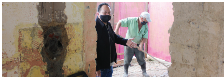
Prefeito visita obra do banheiro da área central.
