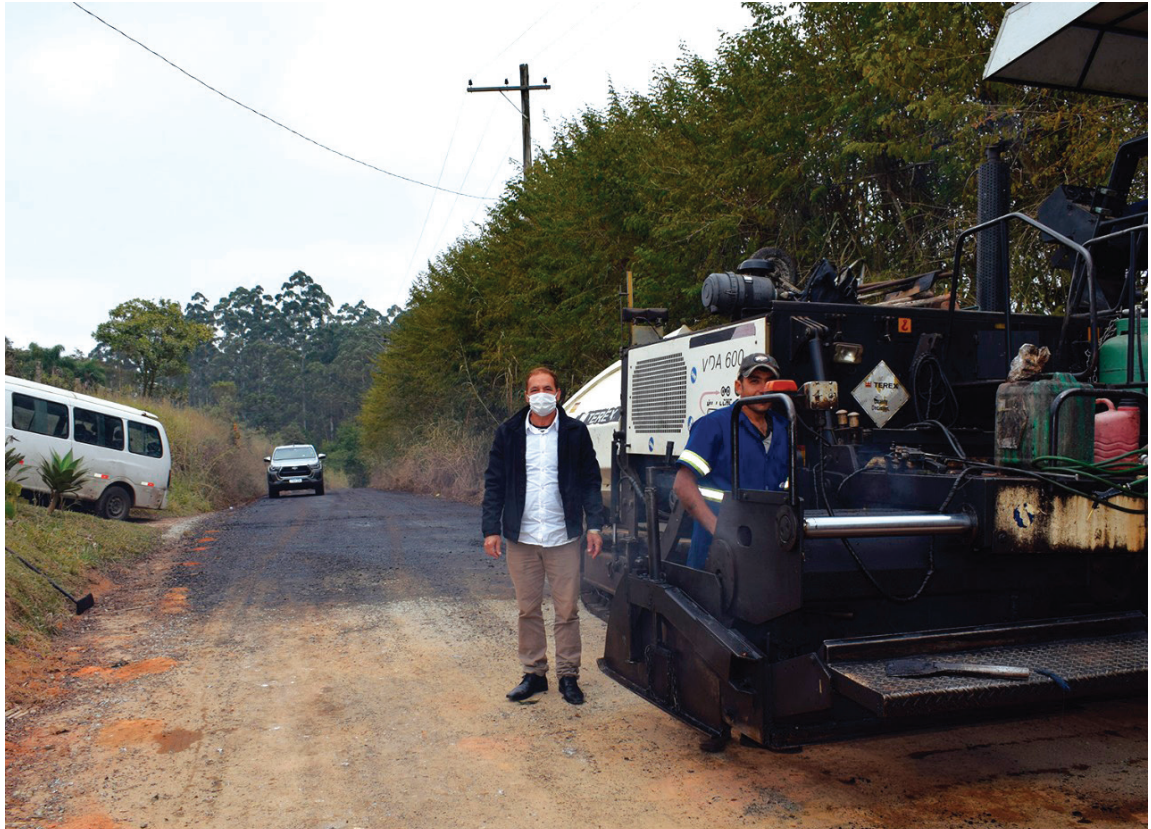
Vereador Tião acompanhando obra de pavimentação no Nirvana
